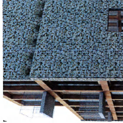
SAMMENSTILLING AF CORTEN OG GABIONER
