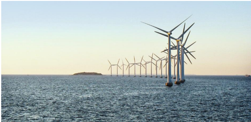
Figur 6-14. Eksempel på opstilling af vindmøllepark på havet – her vindmøller ved Middelgrundsfortet ud for Københavns Havn, der er placeret på en buet række (Foto Rambøll).
